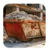
O processo de implementação de um sistema de separação eficiente do RCC dentro do canteiro de obra consiste no uso conjunto de três pontos de coleta: lixeira convencional para o lixo orgânico gerado pelos trabalhadores; bags para acondicionamento dos resíduos das classes B, C, D; e caçambas para descarregamento do entulho da classe A.
